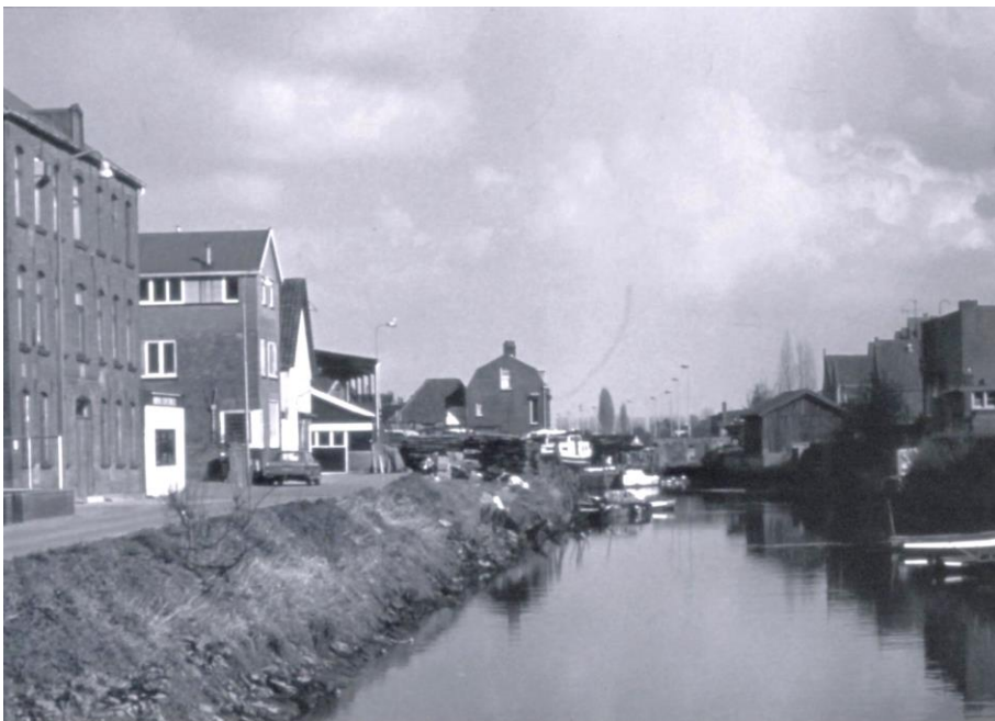
Omslagfoto en foto hierboven: Hobbyhal 1 e witte gebouw links, Fabriek achteraan links met witte dakrand.
