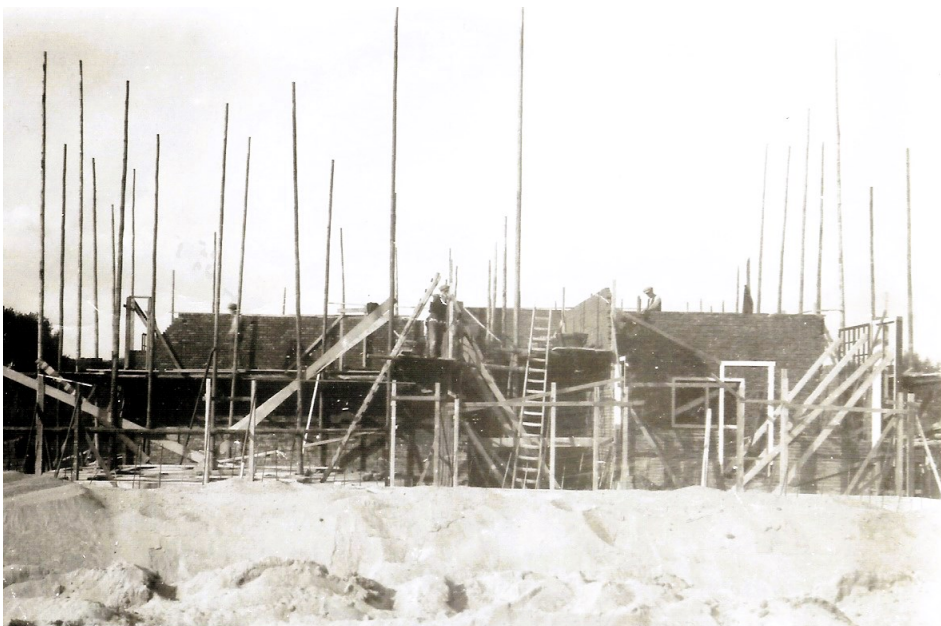
De gasfabriek aan de Scheepmakershaven in 1925 in aanbouw.
