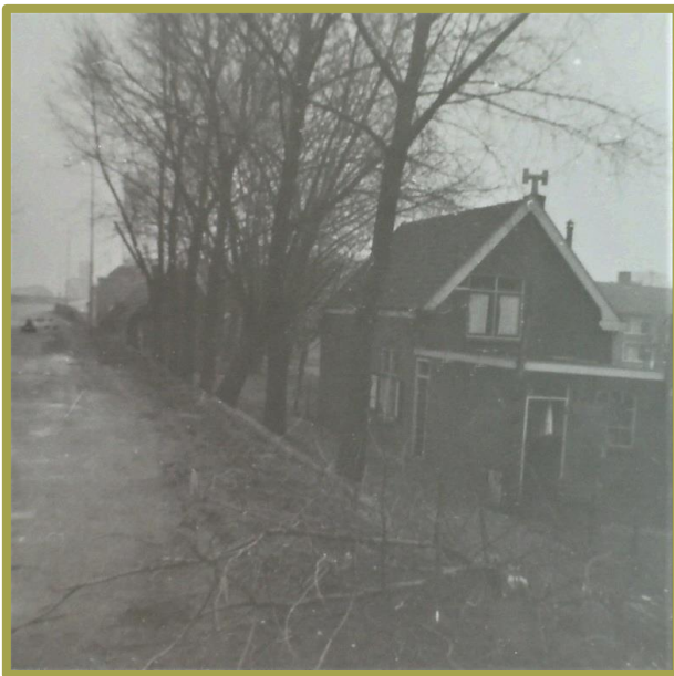
De achterzijde van Evertsenstraat 25 – foto ca 1962
