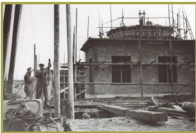
De bouw van de installatie – foto ca. 1951
