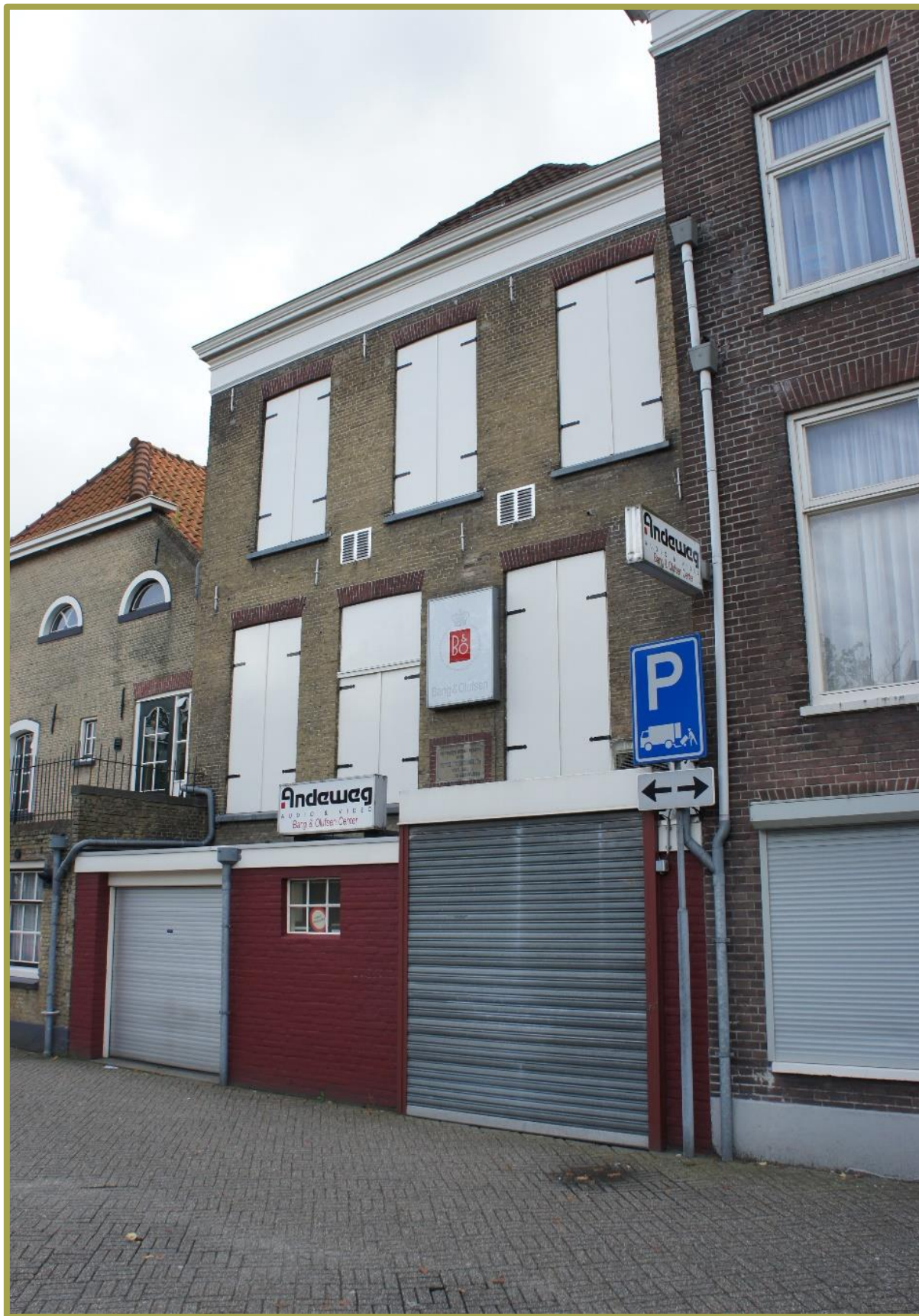
Achterzijde aan de Bierkade. Hier is te zien dat er slechts twee garages zijn gemaakt
