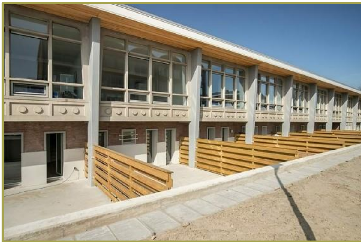
Foto tijdens de verbouwing naar appartementen
