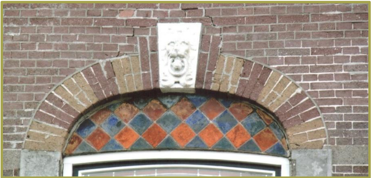
Detail van de gevel boven het venster op de eerste verdieping.
