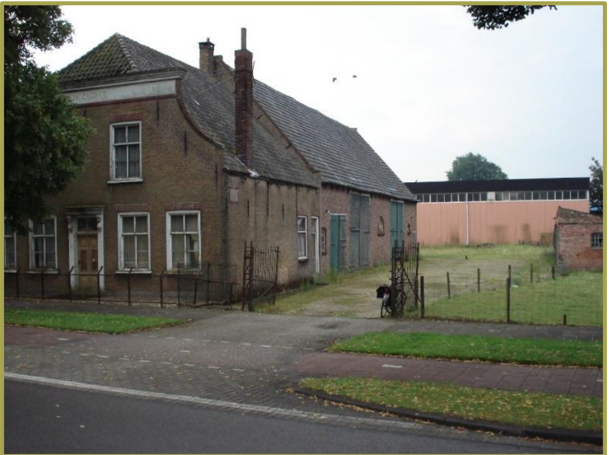
Boerderij Dijkzicht in vervallen staat – foto ca 2007
