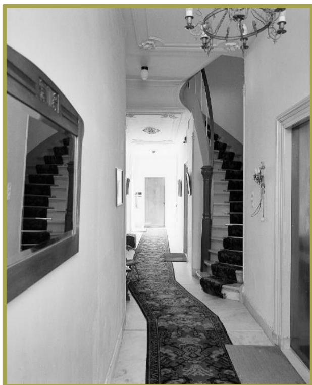
De hal en trapgang van West Voorstraat 6
