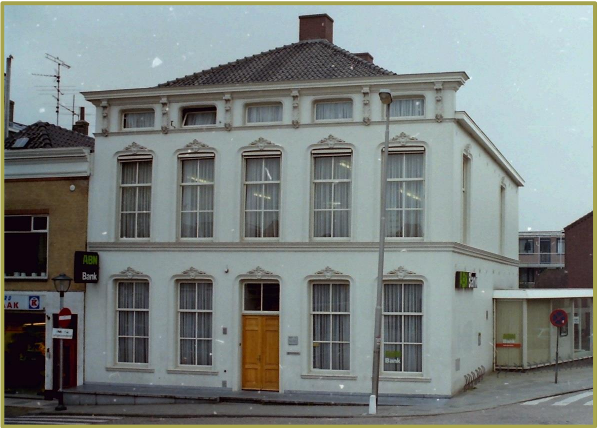
Situatie na de verbouwing. Rechts is nog net de glazen uitbouw zichtbaar
