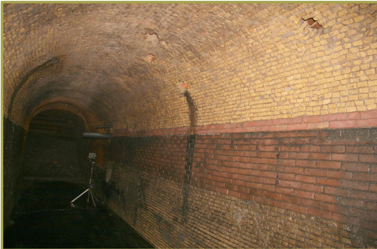
Het nog aanwezige ondergrondse deel van de sluiskoker..
