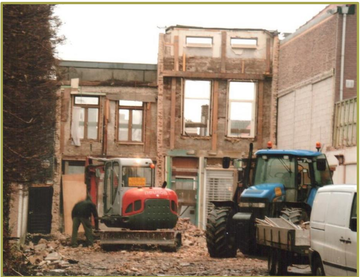
Achter de voorgevels is alles afgebroken.
