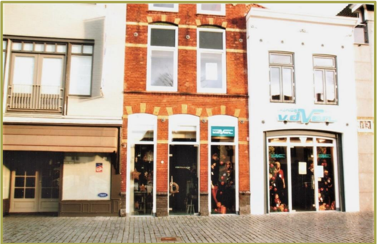
De voorgevels na de verbouwing
