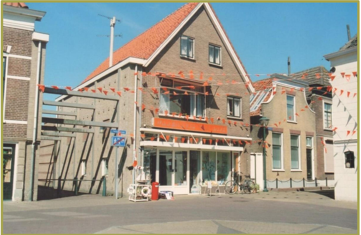
De doorgang naar het Vierwiekenplein uit 1993.
