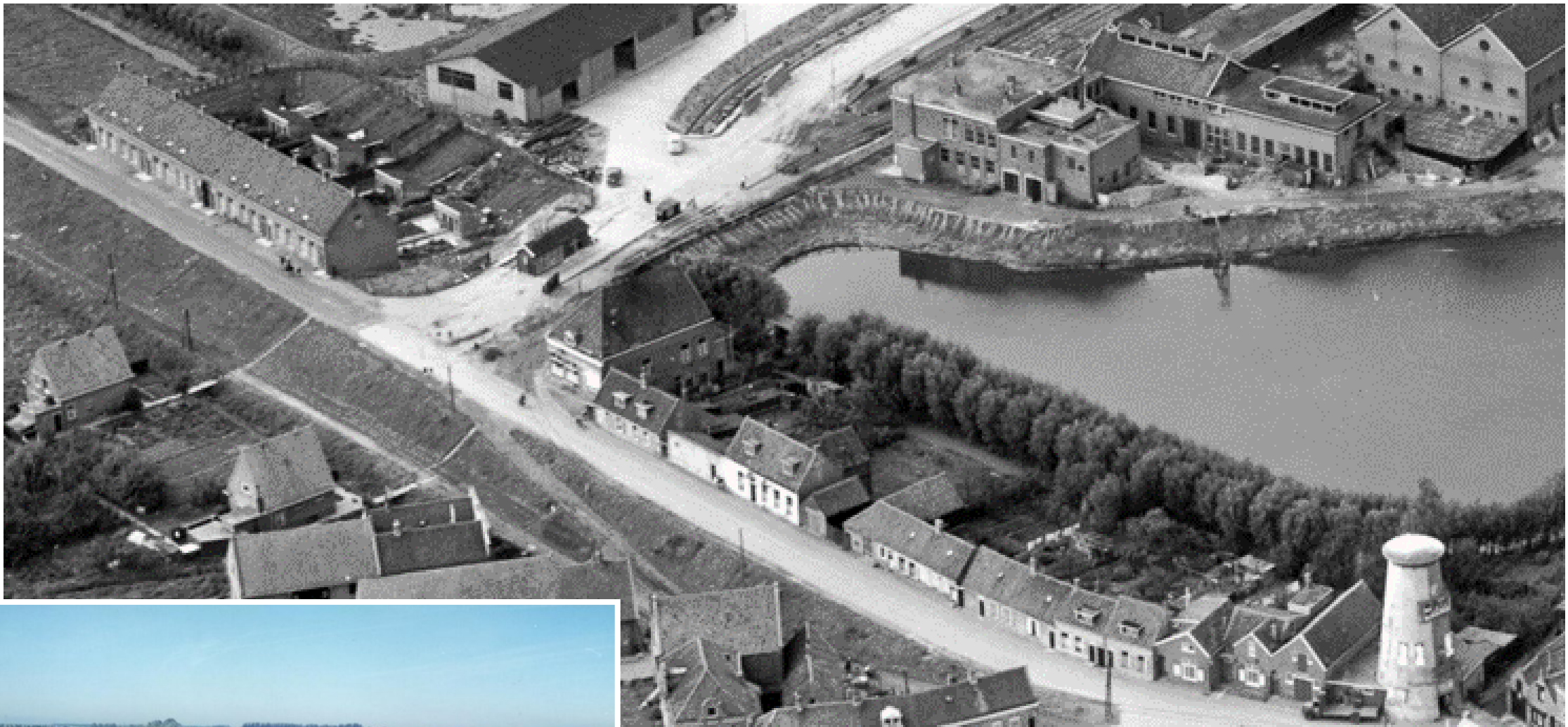
Werken aan de Spuidijk. Situatie afgebroken woningen Spuidijk, 1951
