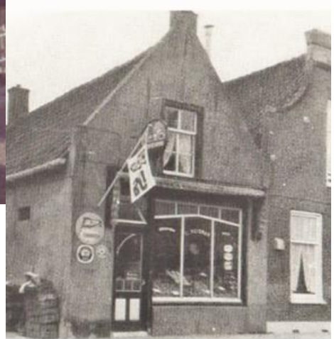
Oost Voorstraat 101 met een stukje zichtbare daklijst van nummer 102 van het oorspronkelijke pand
